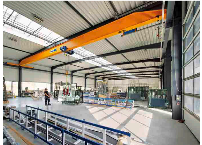
Gevoelig manoeuvreren bij het transport van glas
