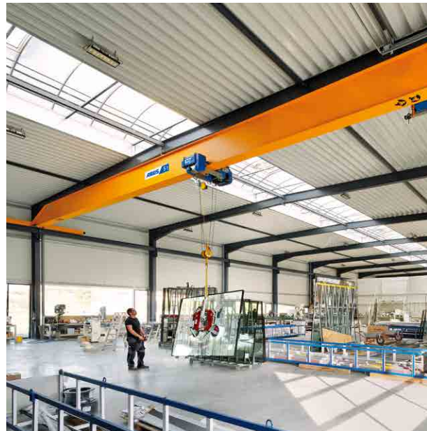
Gevoelig manoeuvreren bij het transport van glas
